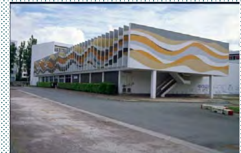
Création du centre des métiers de l'assainissement
